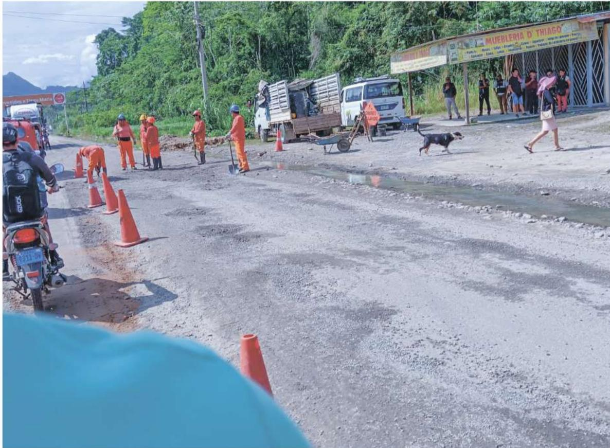
el departamento de San Martín, se puede observar un pésimo estado debido a la inexistencia de cunetas que permitan el drenaje adecuado de las aguas, lo que termina perjudicando el asfalto.
