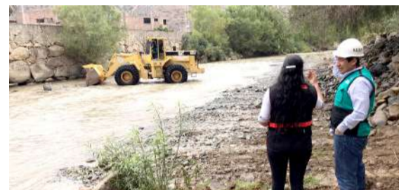
Trabajos iniciaron en Los Carrizales
