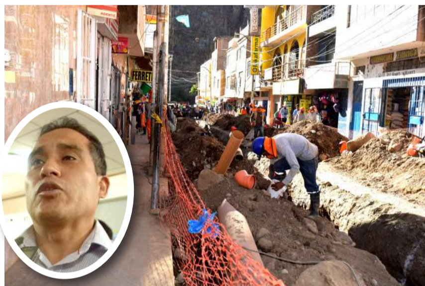
Obra ya lleva nueve años sin poder concluirse
